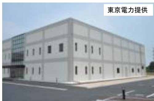
写真B2.2 免震重要棟
