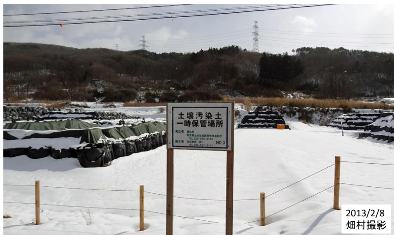
写真B2.4 汚染土の一時保管場所
