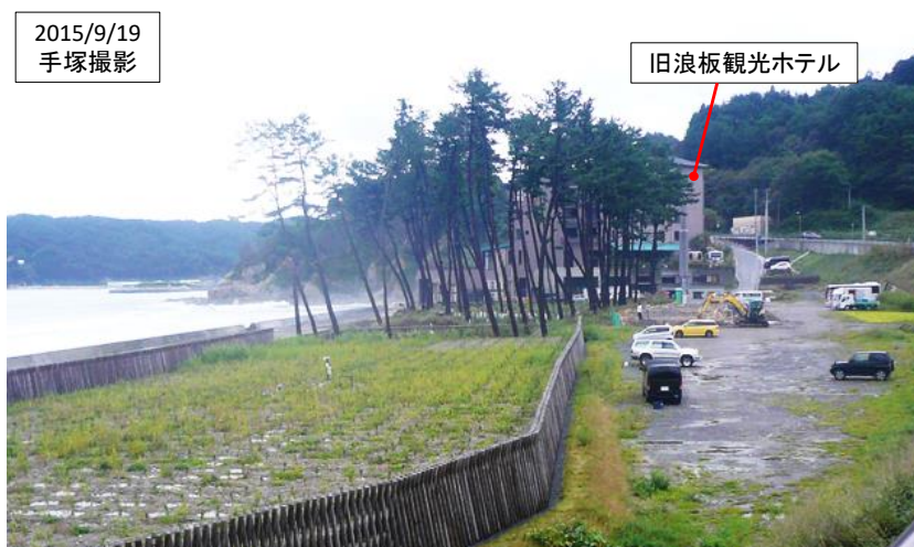
写真C1.2 浪板海岸脇の旧浪板観光ホテル(現三陸花ホテル) (宿泊客は避難して全員無事だった)
