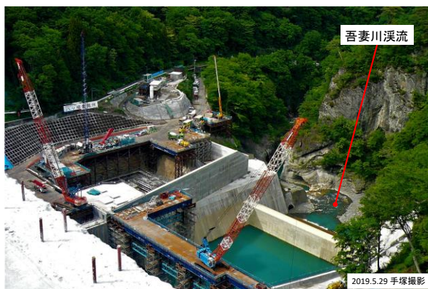
写真D2.3 堤頂から見た工事中的下流側ダム設備と吾妻川溪流
