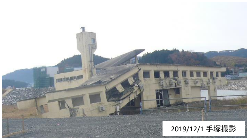
写真D2.8 被災したユースホテル
