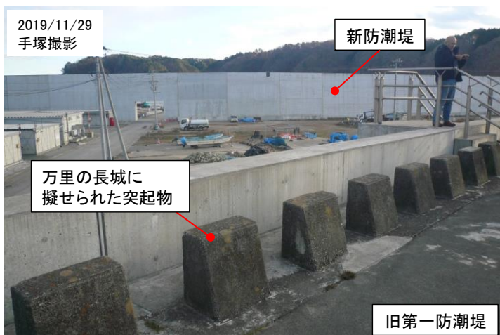
写真D2.5 田老の高さ14.7mの新防潮堤
