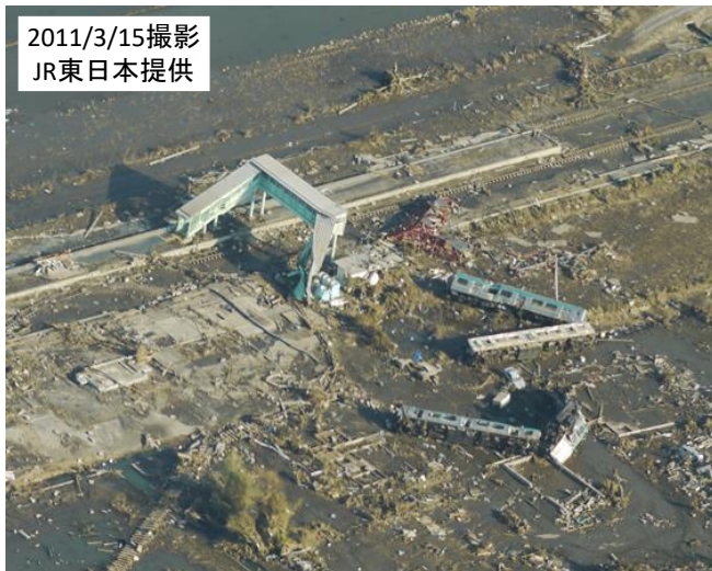
写真B1.23 常磐線新地駅で津波で流された電車
