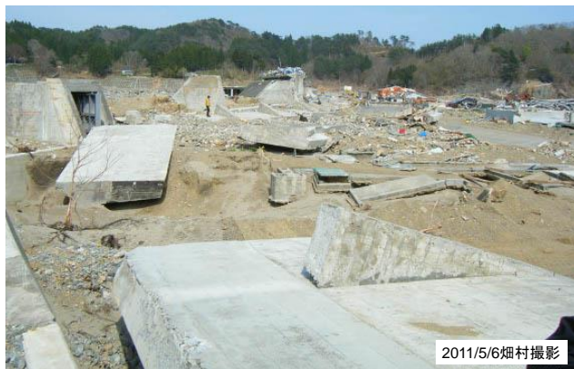
写真B1.7 田老の第2防潮堤
