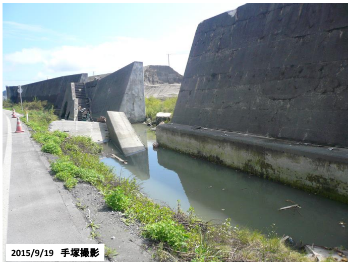
写真B1.1 4年半後も破壊された防潮堤は震災当時のまま
