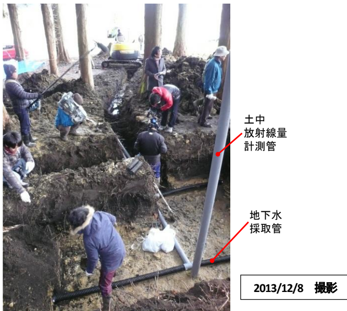
写真A2.6 その場処理の深穴埋め実験の様子
