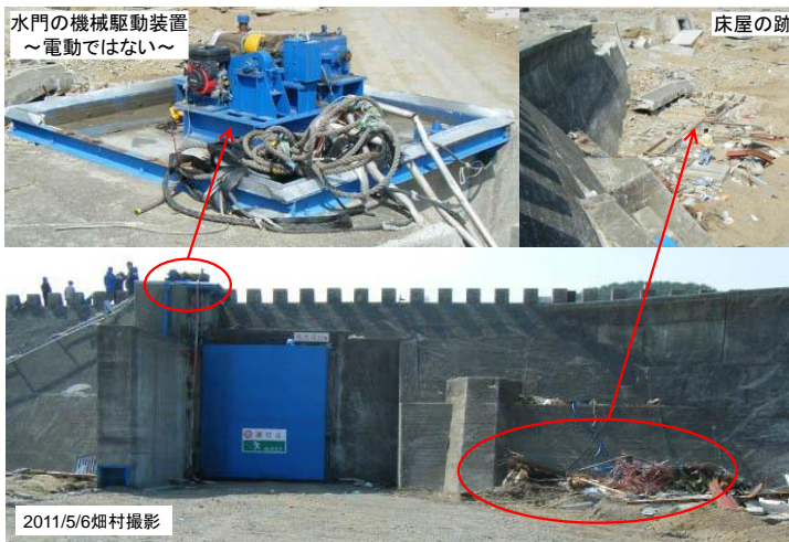
写真B1.9 閉じられた水門と右手の床屋の跡(津波襲来後)
