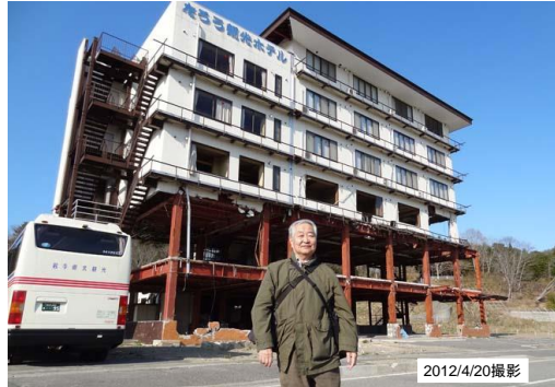
写真B1.11 津波に破壊された「たろう観光ホテル」
