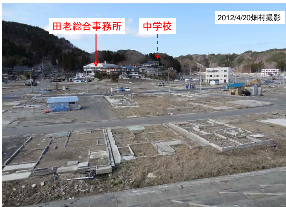
写真B1.10 第1防潮堤内の様子
