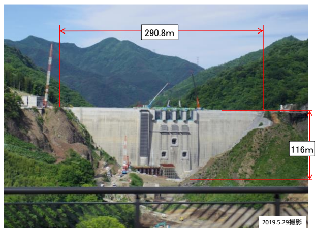
写真D2.2 ハッ場大橋(上流側)から見た堤体
