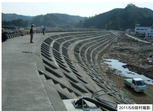
写真B1.6 健在だった田老の古い防潮堤の背面
