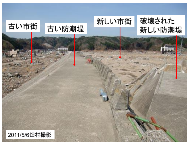
写真B1.13 田老防潮堤の交差部分から見た 新旧防潮堤内部の被害の違い
