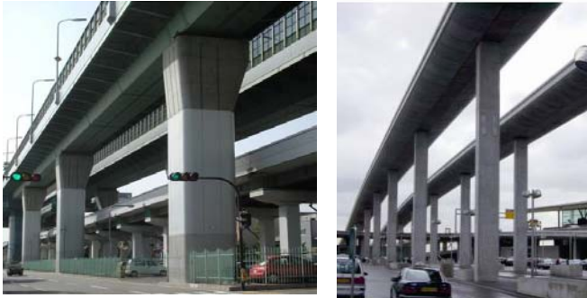
図一16 阪神高速道路の橋脚とソウル・ド・ゴール空港のアクセス道路の橋脚 3)
