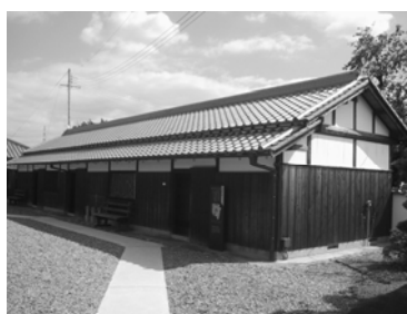
塾と薬剤調合・保管の建屋
