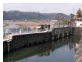
羽村第1取水口
