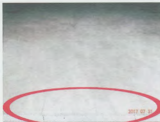
床のひび割れの状態（ひび割れが非常に多い）
