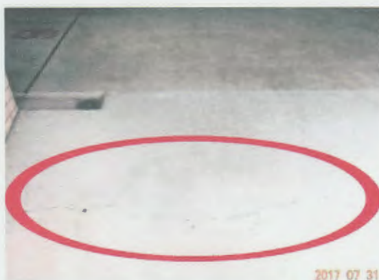
床のひび割れの状態（ひび割れが非常に多い）
